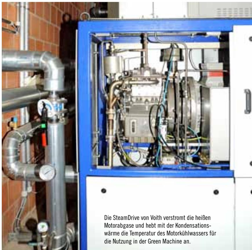
Die SteamDrive von Voith verstromt die heißen Motorabgase und hebt mit der Kondensationswärme die Temperatur des Motorkühlwassers für die Nutzung in der Green Machine an.
